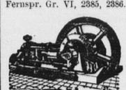
Körtings Dieselmotoren liegender Bauart
