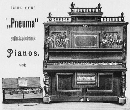
Elektrischer Betrieb mit direktem Anschluss an vorhandene Lichtleitung, resp. mit Akkumulatoren oder Dreh-Kurbel-Betrieb.
