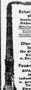
2 Schornsteine je 70 m hoch, 2.50 o. l. Durchm. mit Flugaschenfänger
