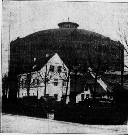
Gasmesserwerkstatt und Gasbehälter in Fuhsbüttel vom Südosten gesehen
