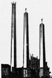
3 Schornsteine je 102,20 m hoch, 4,50 o. l. Durchm. für H. E. W. Kraftwerk Tiefstack
