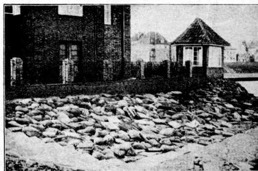
Sturmschäden in Cuxhaven. Unterwachte Böschung, die bei dem Hochwasser am 13. Oktober mit Sandsäcken ausgefüllt wurde, um den Einsturz der Häuser zu verhindern.
