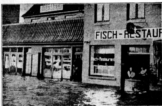
Überschwemmung in Cuxhaven am 13. Oktober 1926. Der orkanartige Sturm, der in den Küstengebieten der Nordsee vom 6. bis 13. Oktober große Schäden verursachte, setzte auch in Cuxhaven die niedrig gelegenen Straßen am Hafen unter Wasser.
