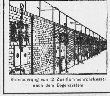
Einmauerung von 12 Zweiflammrohrkessel nach dem Bogensystem
