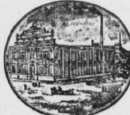
Dampf- u. Warmwasserheizung, Kaiser Wilhelm- Str. 110
