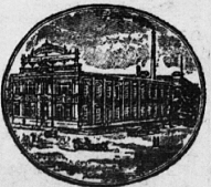
Dampf- u. Warmwasserheizung, Kaiser Wilhelm-Strasse 110
