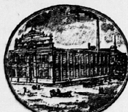
Dampf- u. Warmwasserheizung, Kaiser Wilhelm- Strasse 110
